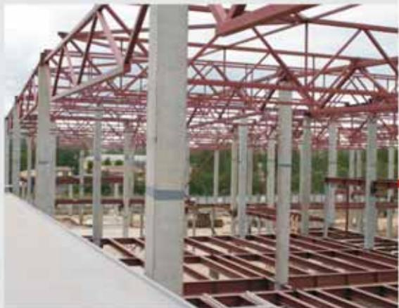
ОАО «Промприбор» предлагает конструкцию навеса, которую можно быстро собрать из типовых элементов по месту установки. Разработанный нами тип конструкции надёжен, так как способен выдержать снеговую нагрузку до 200 кг/м<sup>2</sup> и является самым легким по весу среди существующих аналогов. Все элементы конструкции являются коррозионно устойчивыми, что обеспечивается технологическим процессом горячего цинкования.
